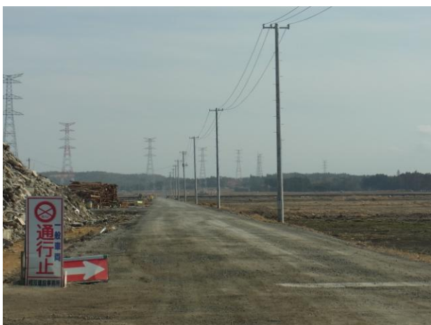
電柱は仮設、海側に旧送電線鉄塔が並ぶ。倒壊した鉄塔は撤去され、送電線は撤収された。
