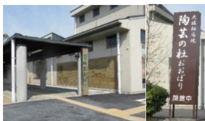
改修された「陶芸館」
