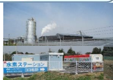
棚塩工業団地『水素工場』
