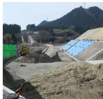
大熊西工業団地造成中
